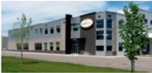
Montpak International (Rigoville) – Québec, Canadá Imagem: Google Street View
